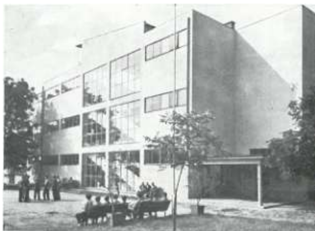
Obr. 2: Nová budova pokračovací dřevařské průmyslové školy (ulice Tyršova)
